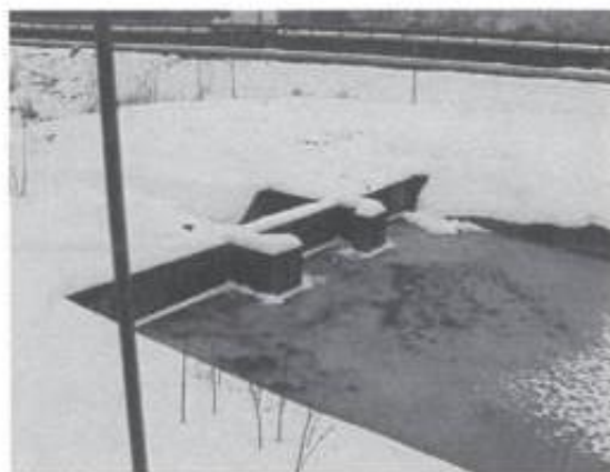
Bassin de décantation, en amont combe Royer
