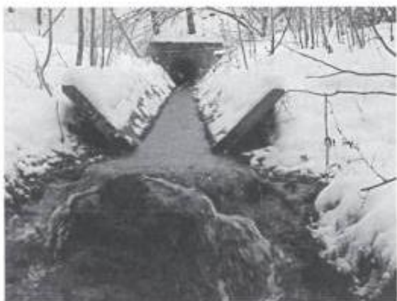
Busage sous autoroute, combe Royer
